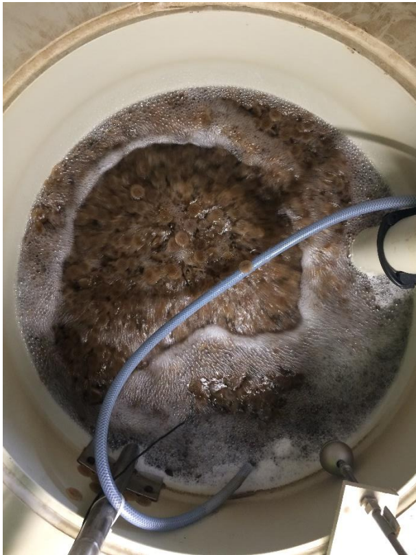
Figur 2. Luftad bassäng innehållande biofilmsbärare i rörelse även kallad MBBR.
