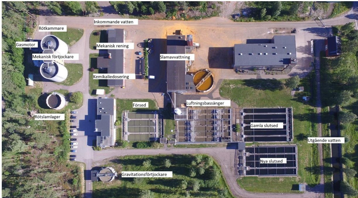
Figur 1. Flygfoto av Främby reningsverk med några av de olika delarna och processerna utmärkta. Vissa av byggnaderna som kan ses på bilden hör till den separata gruvvattenreningen och inkluderas inte i projektet.
