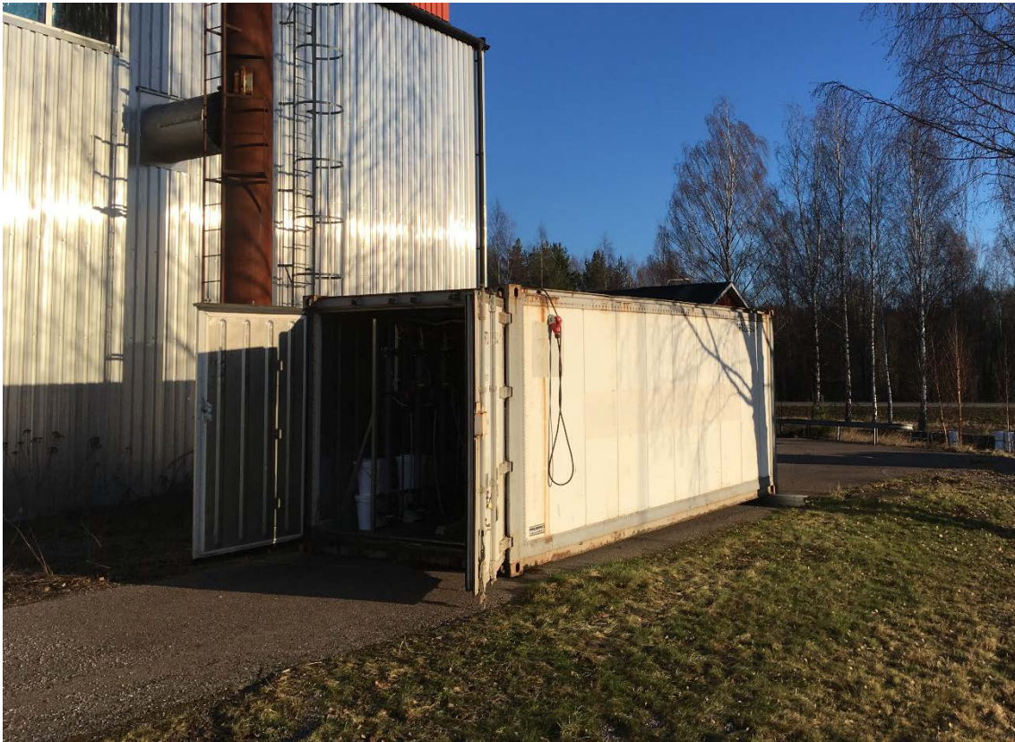
Figur 1. Utsidan av pilotanläggningen.
