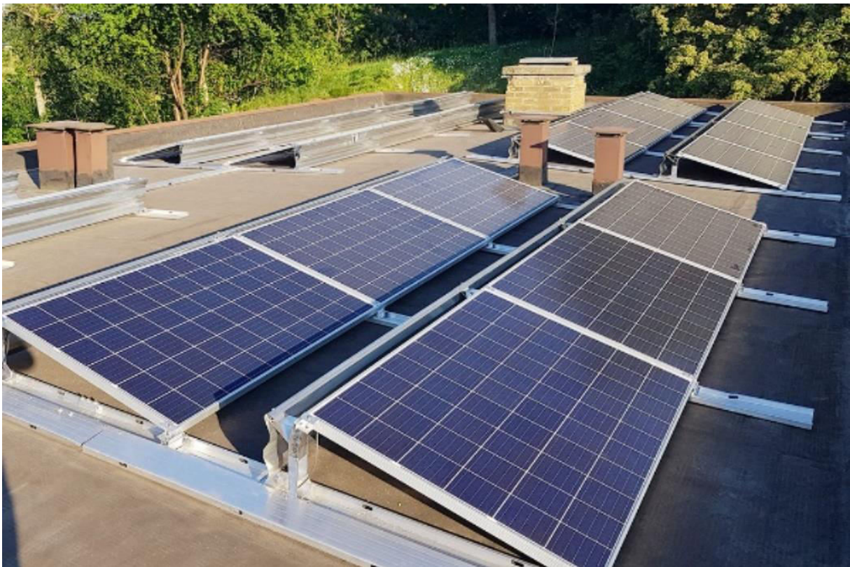
Figur 7. Monteringsystem med ballast (SolNord, u.d.).
