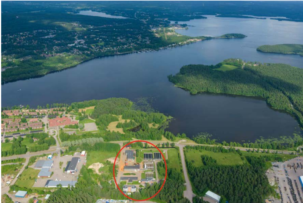
Flygbild över Främby reningsverk.
