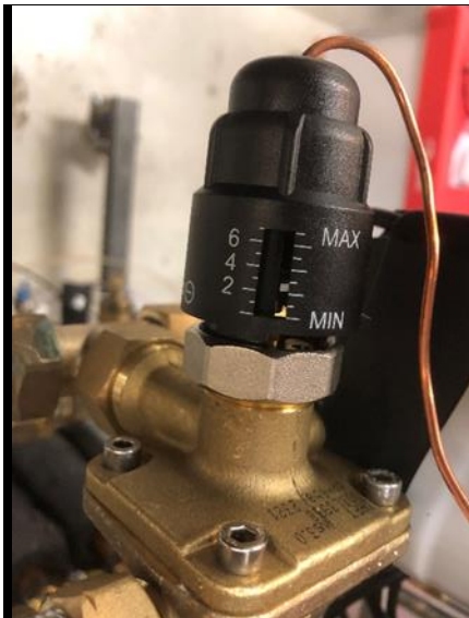
Figur 2. Varmvattenregulatorns inställning för dynamisk provning.
